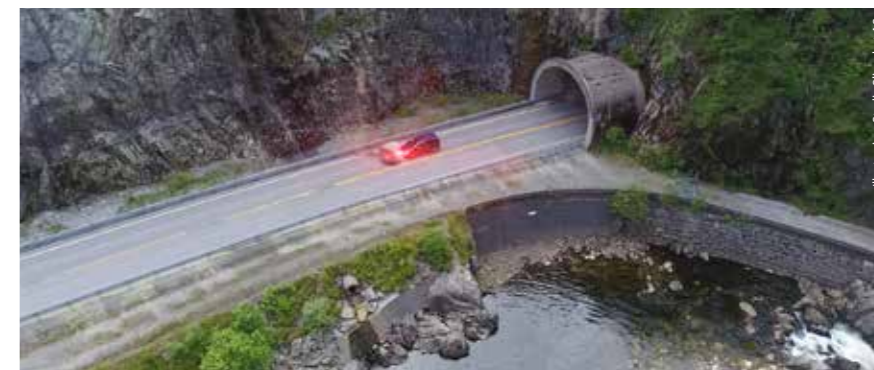
Bilde 1: En stor stein ramler ned på veien fra en bratt fjellside. Bare flaks gjør at en passerende bil i dette tilfellet ikke blir truffet.
